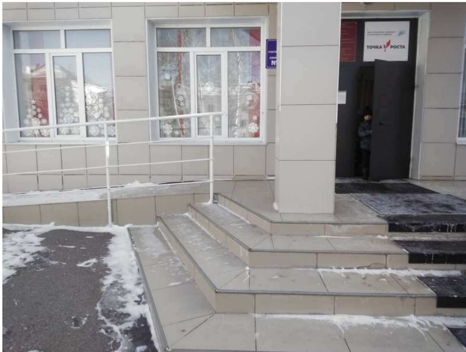
Фото №1. Лестница наружная, пандус наружный, дверь входная, входная площадка
