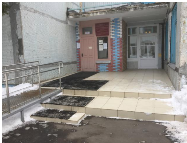
Фото № 4 Лестница (наружная)
