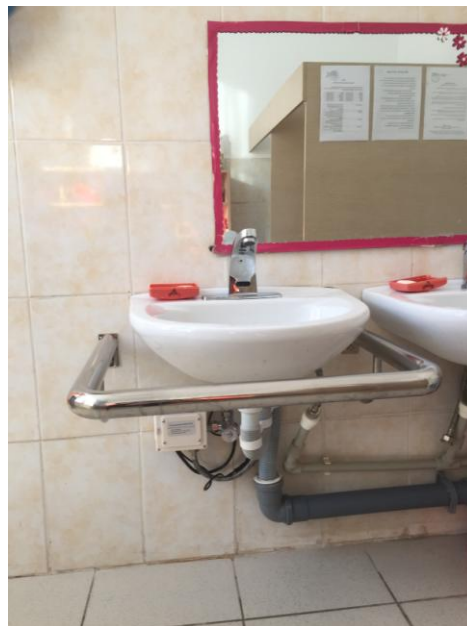
Фото № 12 Туалетная комната
